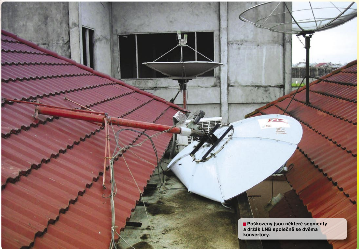
■ Po: Jaká škoda – 1,8 m parabola se vlivem silných větrů zhroutila.
