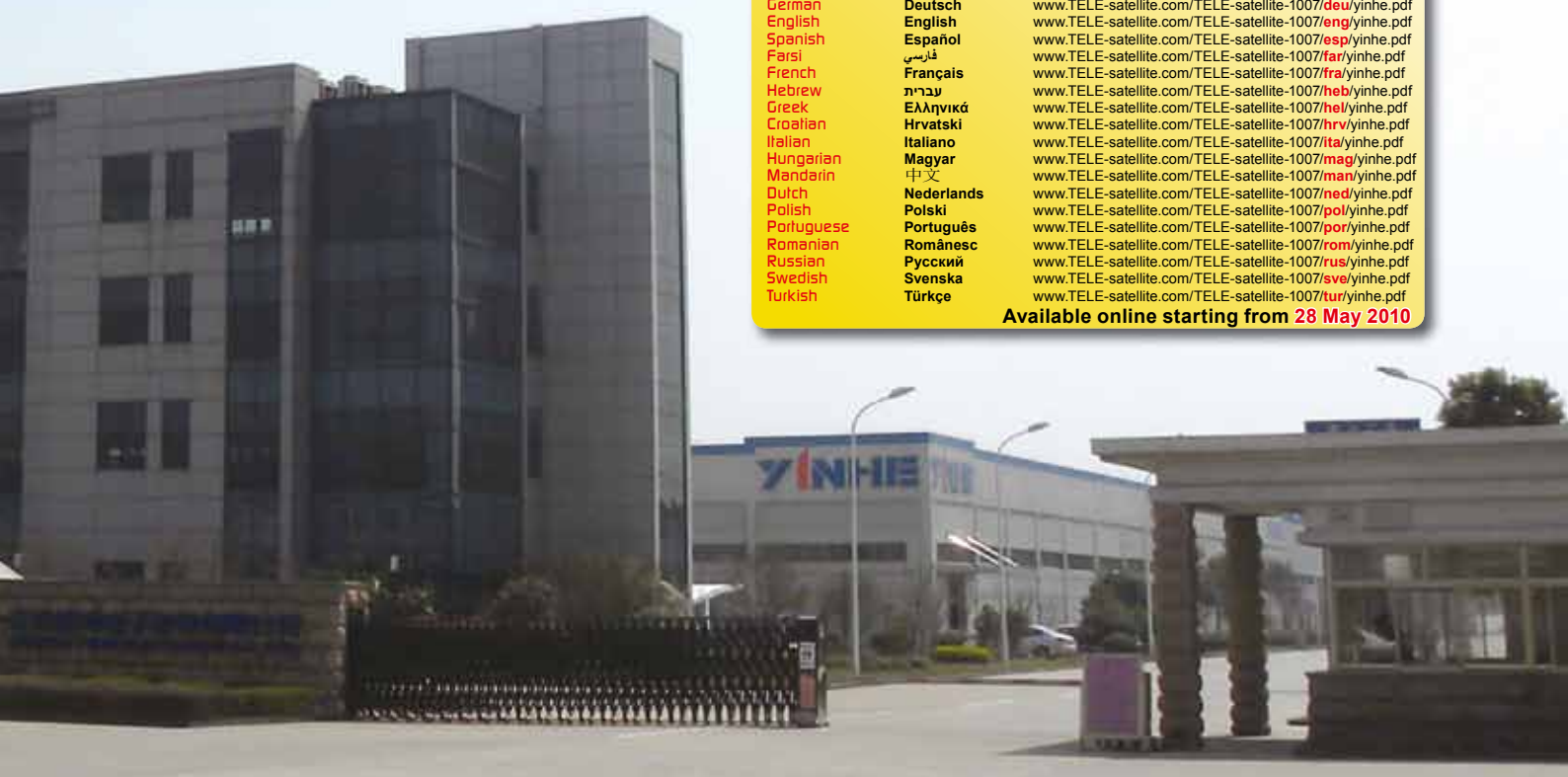
■ YINHE, hlavní brána. Administrativní budova je nalevo, za ní výrobní haly. Pracuje zde 1500 zaměstnanců.
